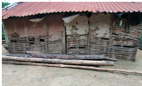
Figura 6.12. Marco de madera que da soporte a un techo de lámina con elementos de madera y paredes de bajareque
