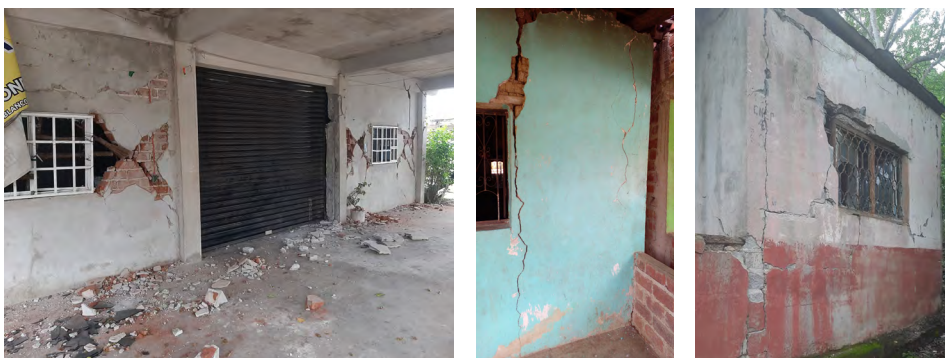
Figura 6.6. Fallas en muros de mampostería sin castillos en aberturas de puertas o ventanas
