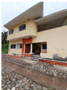
Figura 6.17. Deficiencias de estructuración que dieron origen a daños
