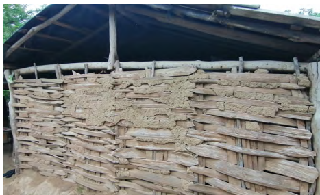
Figura 6.12. Marco de madera que da soporte a un techo de lámina con elementos de madera y paredes de bajareque
