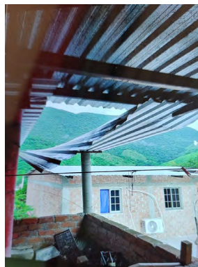
Figura 6.17. Deficiencias de estructuración que dieron origen a daños
