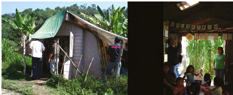
Figura 1. Dos aspectos (exterior e interior) de un aula temporal multigrado improvisada
