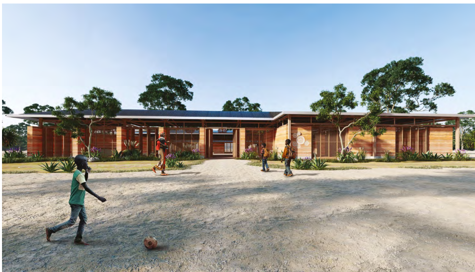
Figura 5. Fachada principal de la escuela secundaria Sambou Toura Drame
