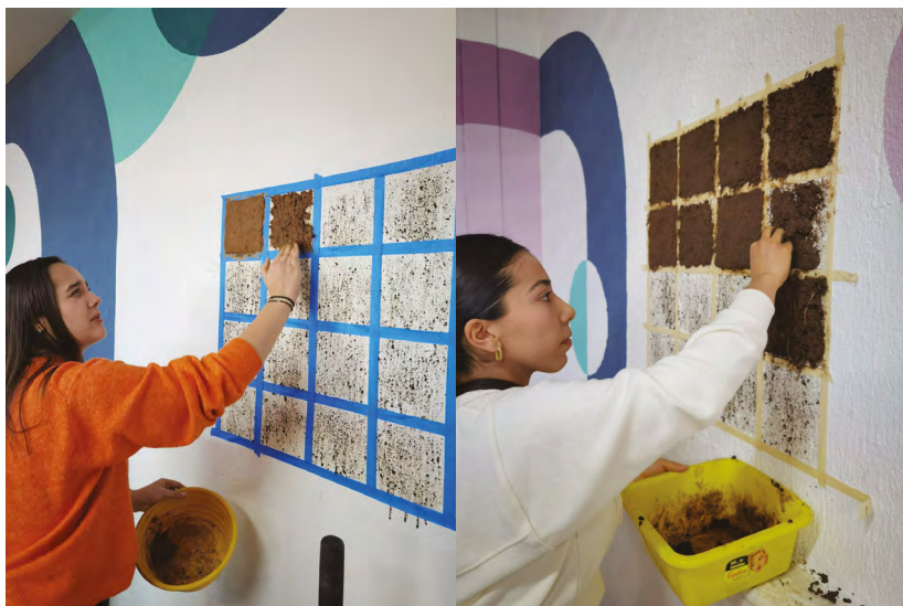
Figura 4. Aplicación de los revestimientos naturales de tierra
