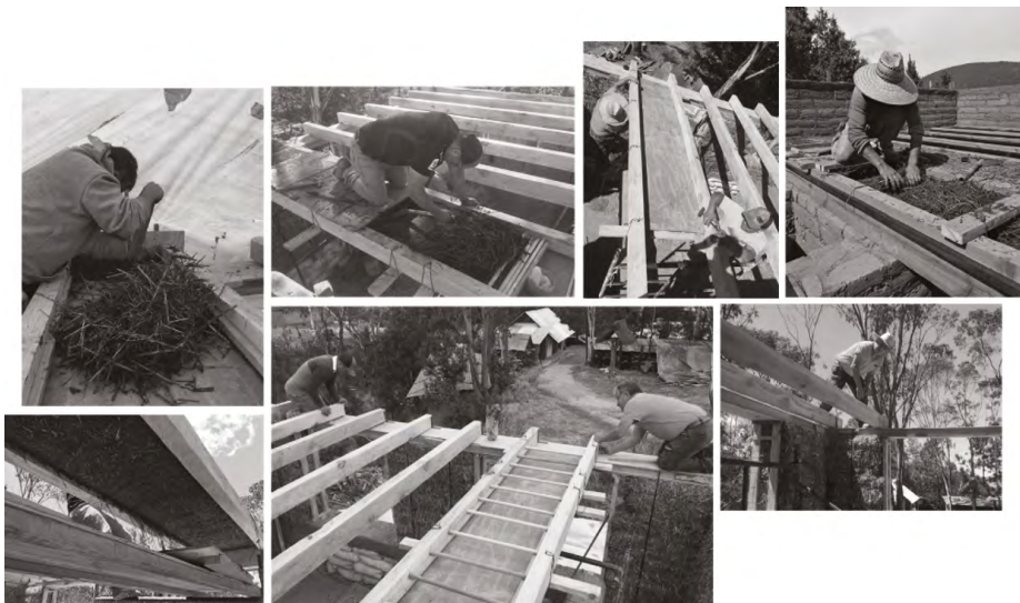
Figura 1. Proceso constructivo del entrepiso de pajarcilla
