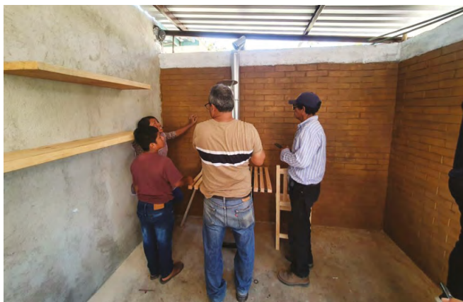
Figura 6. Instalación de la estufa ecológica Ecosofía
