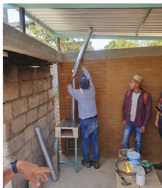
Figura 16. Instalación de estufa ecológica Ecosofía
