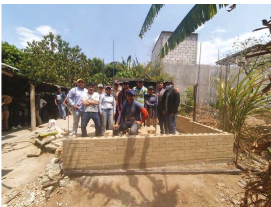
Figura 13. Proceso constructivo de los muros de BTC
