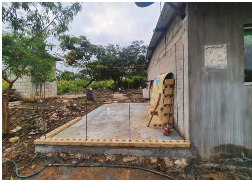
Figura 3. Cimentación y primera hilada de BTC
