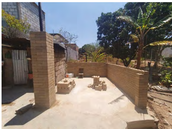
Figura 15. Avance de la construcción de la Ecocina
