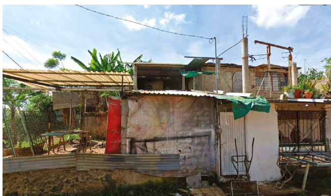
Figura 5. Vivienda de la Colonia Santa Lucía I
