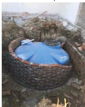
Figura 13. Colocación de mampostería con morteros de cal para cisterna
