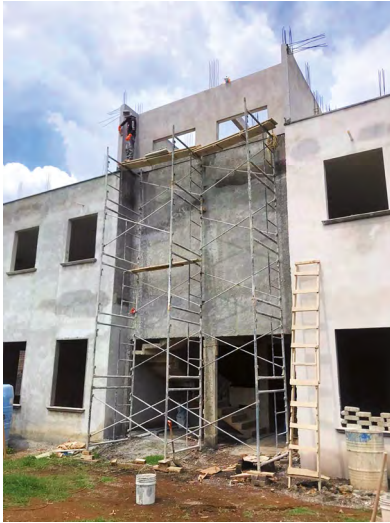
Figura 4. Obra con aplanado de morteros de cal. Morelia, Michoacán
