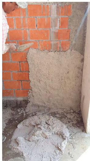
Figura 11. Colocación de mortero de cal en muro de tabique mecanizado
