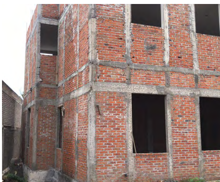
Figura 12. Pegado de tabique rojo y tabicón
