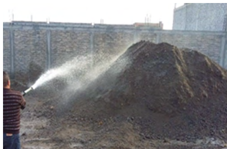
Figura 17. Incorporación de humedad
