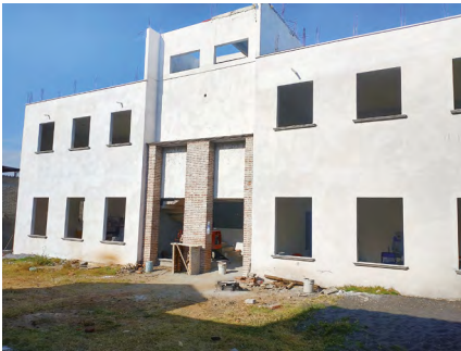
Figura 6. Recubrimiento fino con mortero de cal en estado endurecido
