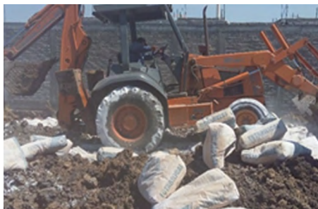
Figura 16. Suministro y mezclado de la cal
