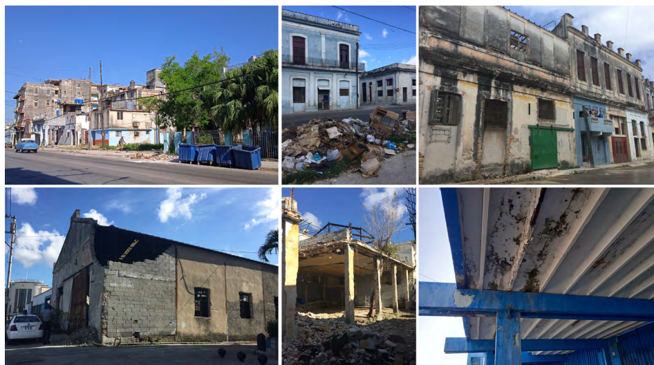
Figura 2.3. Problemáticas arquitectónico-urbanas del sitio de estudio
