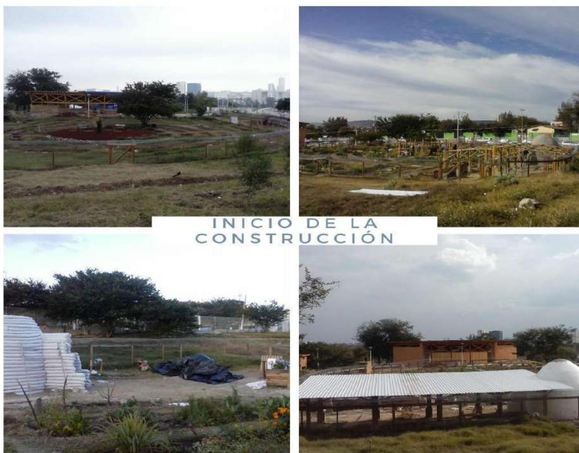
Figura 5. Proceso de construcción de espacios del Parque Agroecológico Zapopan. Fuente: Elaboración propia (2014 y 2015).
