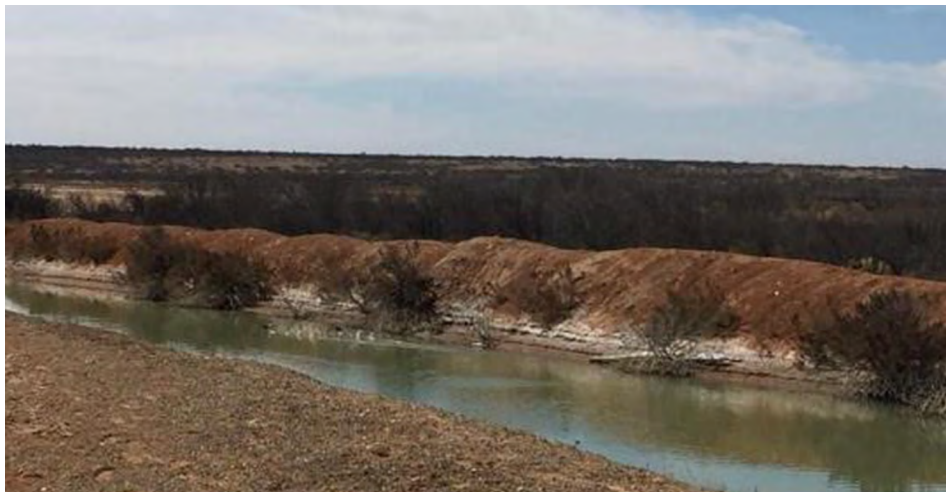
Figura 8.11. Canal de salmuera excavado en las inmediaciones de la laguna de Zaldívar
