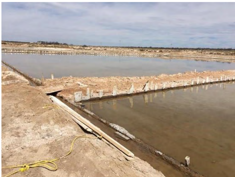
Figura 8.12. Tablón para el aplanado de las piletas cristalizadoras
