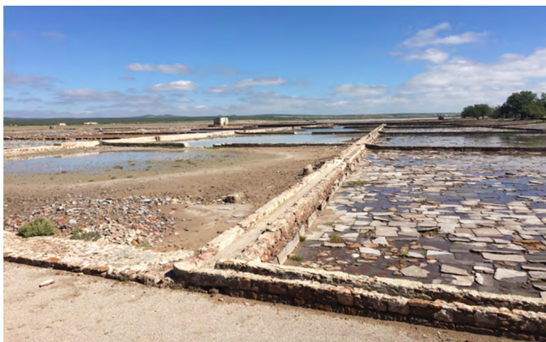
Figura 8.3. Canal de mampostería
