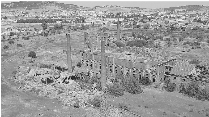
Figura 9.7. Imagen que muestra el estado de ruina de los inmuebles. En ella encontramos en primer plano la Fábrica de Zinc derruida en la que solo permanecen dos de sus chimeneas, tras ella, los restos del Almacén de Productos Refractarios, ambos construidos en hormigón armado y, al fondo, la Fábrica de Ácido Sulfúrico de la cual solo se conserva su chimenea
