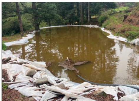
Figura 5.4. Reservorio de agua principal de capacidad de 1,500,000 m 3
