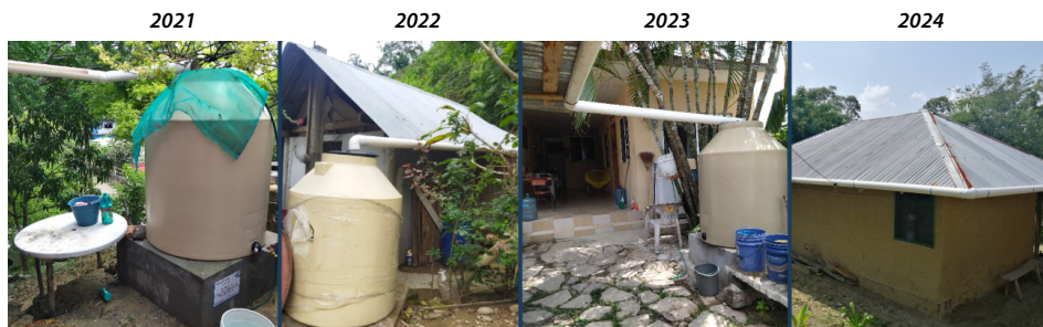
Figura 9.1. Sistema de captación pluvial en zona rural de Tantoyuca, Veracruz
