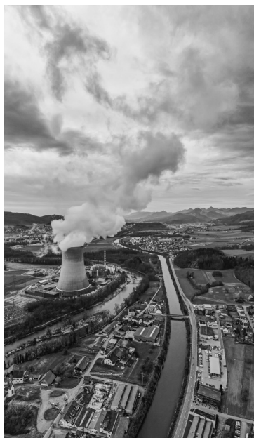
FIGURA 10. Central térmica de generación de energía
