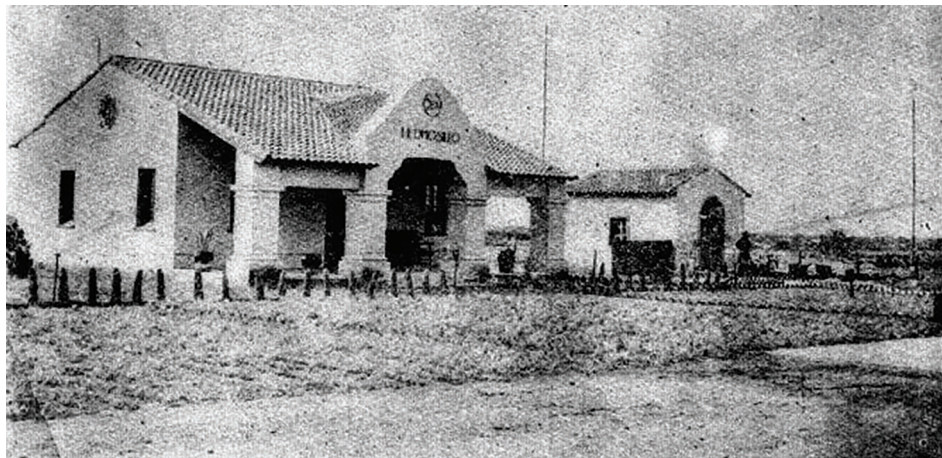
Figura 5. Aeropuerto Civil de Hermosillo previo a su demolición
