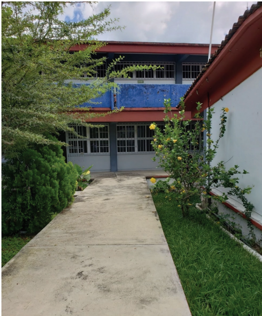
FIGURA 5. Acceso al edificio de Geografía
