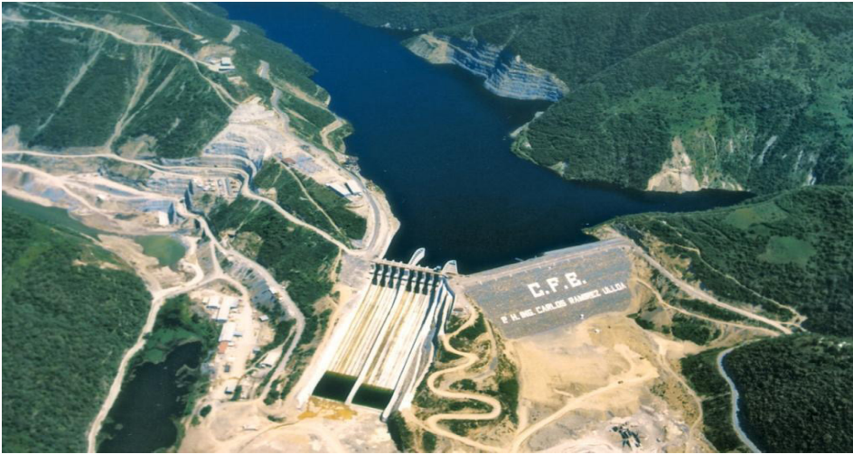
FIGURA 2. Presa El Caracol
