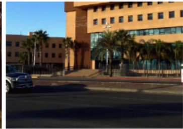
FOTOGRAFÍA V.6. Vista al paramento poniente, periodo frío. FUENTE: Elaboración propia.
