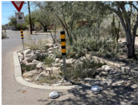
FOTOGRAFÍA III.1. “Oreja” en vialidad de Tucson, Estados Unidos, para disminuir la escorrentía y almacenar agua para irrigación de área verde.
