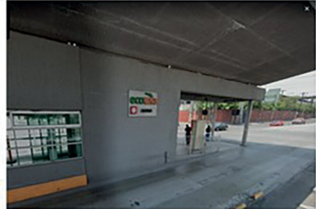
Estación ASARCO Ecovía
