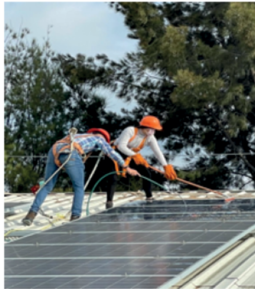
Figura 6. Actividades de mantenimiento en la cubierta de las fuentes de energía fotovoltaica.
