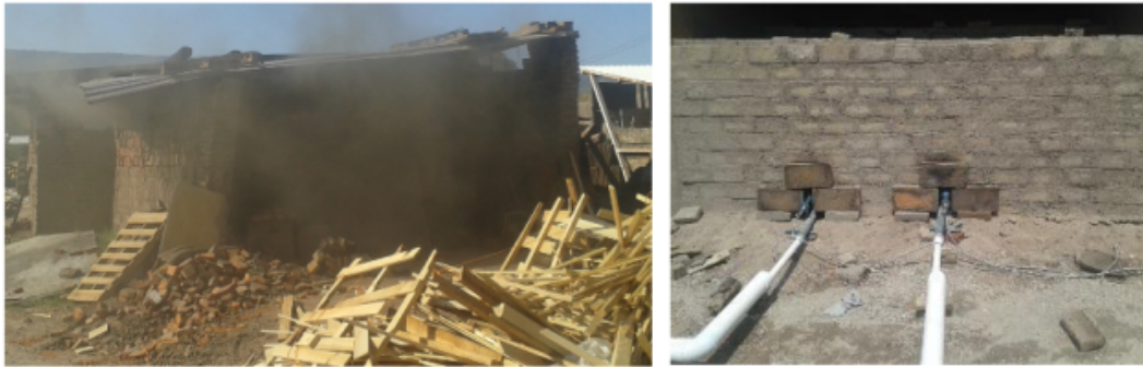
Figura 7. Operación del horno. (a) Combustión abierta del horno tradicional. (b) Quemadores de alta eficiencia a gas LP
