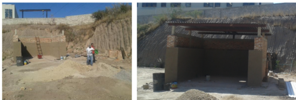
Figura 5. Horno ecológico. (a) Cuerpo. (b) Techo
