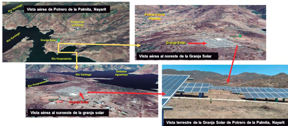
Figura 5. Vistas aéreas de la granja solar en Potrero de la Palmita, Nayarit, México
