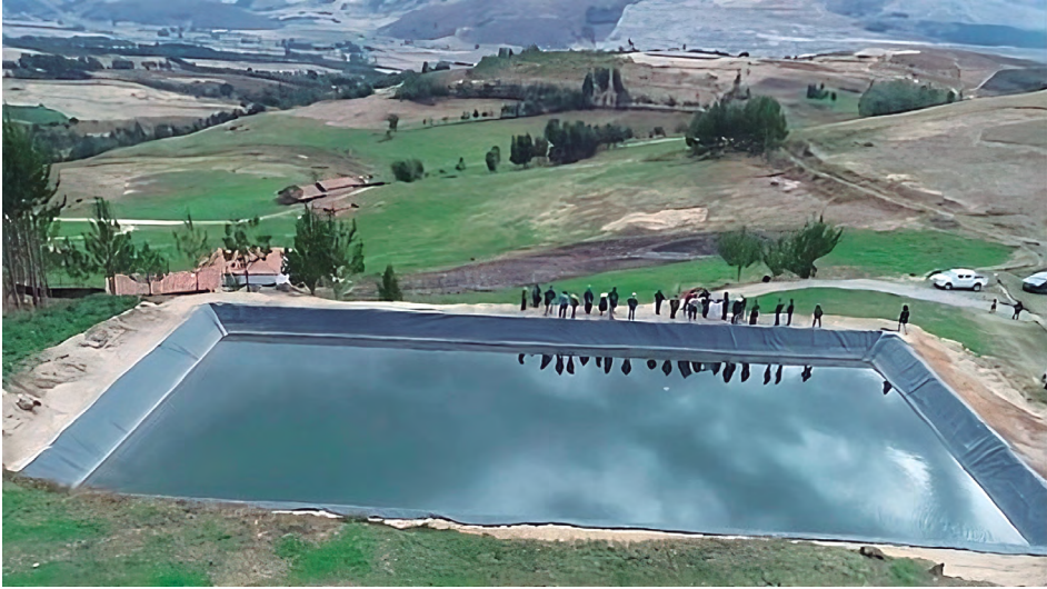
Figura 2. Reservorio de agua para riego
