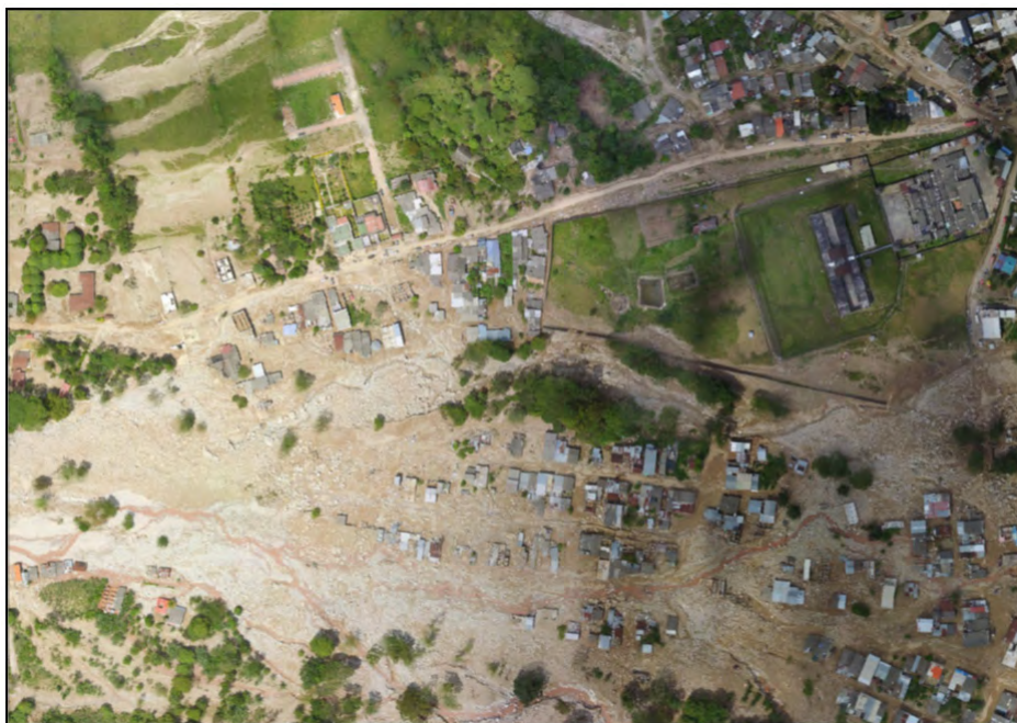
Figura 2. Vista aérea de los efectos de la avenida torrencial de Mocoa
