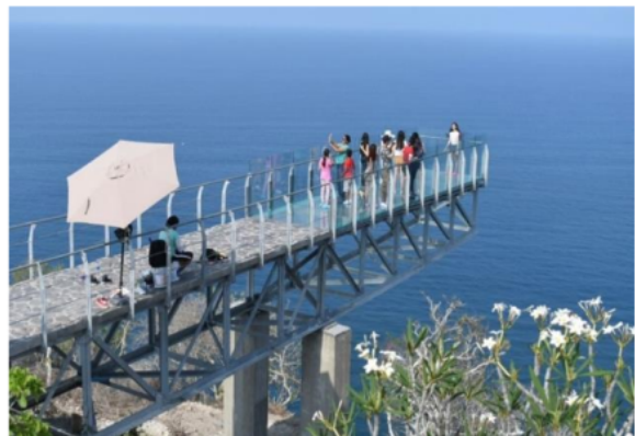
Figura 8. Remodelación del Faro
