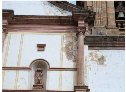
Figura 5.5. Fachada principal y detalles de daños en el segundo nivel, frontón y arranque del campanario
