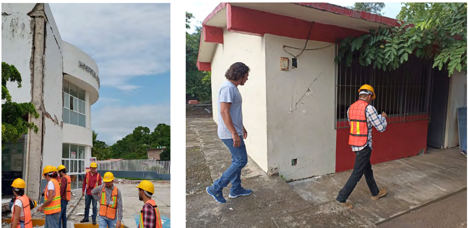
Figura 2.20. Brigadas de inspección estructural y uso de equipo de inspección
