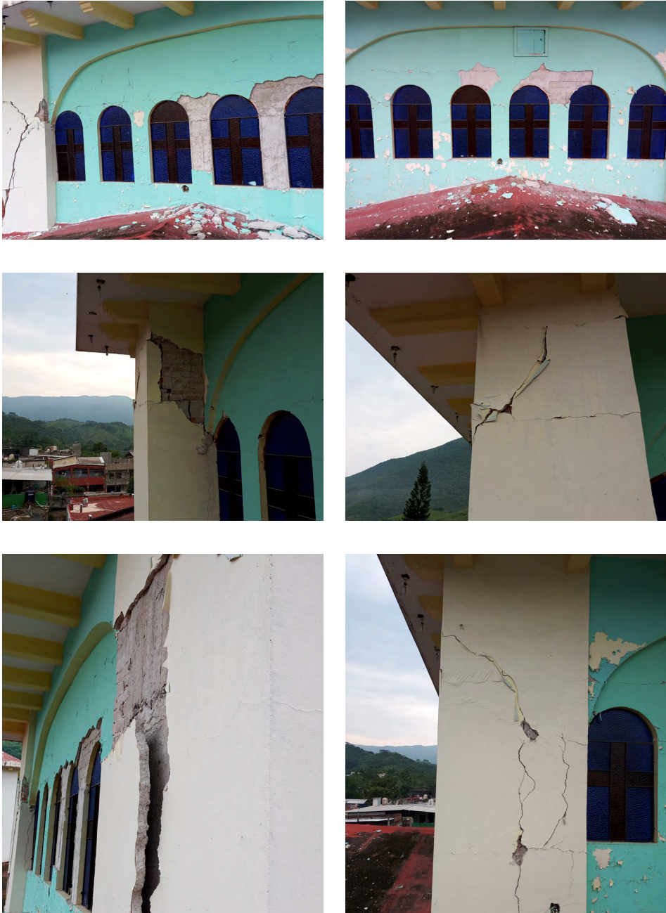
Figura 5.9 .Daño en el tambor y ventanales de la parte superior
