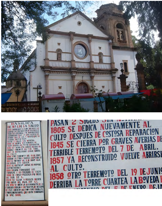
Figura 5.1. Descripción de daños en la Basílica durante los temblores de 1845 y 1858
