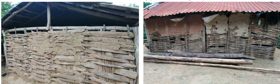
Figura 6.12. Marco de madera que da soporte a un techo de lámina con elementos de madera y paredes de bajareque
