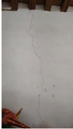
b) Muros de la sacristía
