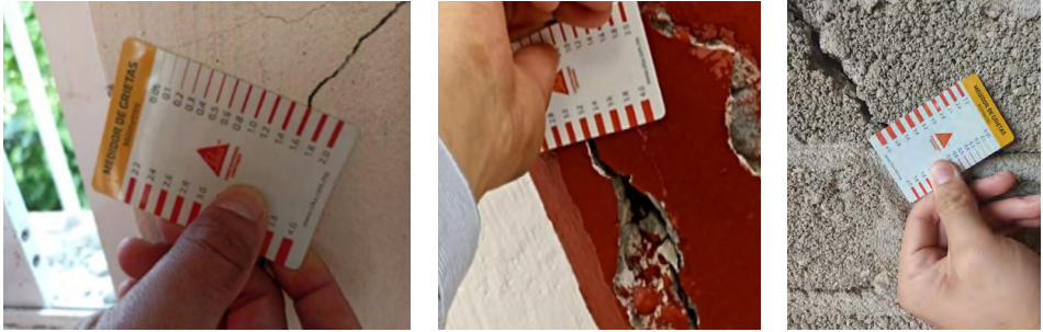
Figura 2.19. Utilización de los grietómetros durante las evaluaciones
