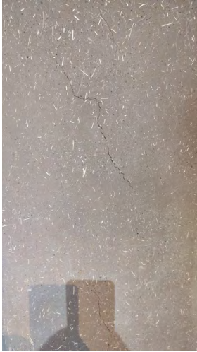
a) Muros con aplanado de adobe
