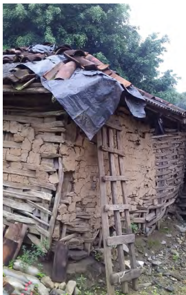
Figura 6.16. Techo de lámina de cartón sobre un marco de madera y paredes de tabicón sin cementante
