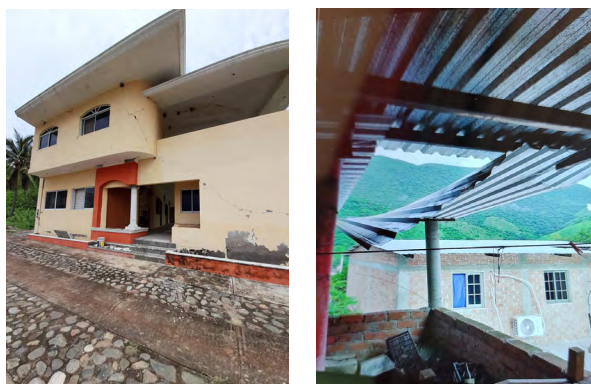
Figura 6.17. Deficiencias de estructuración que dieron origen a daños
