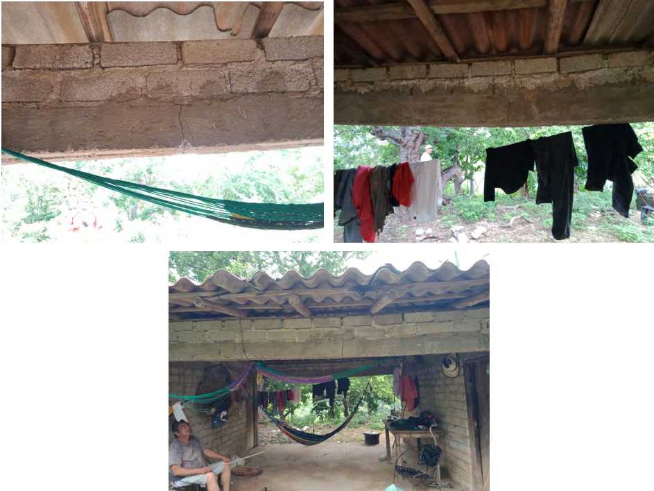
Figura 6.21. Falla por flexión en una viga de concreto debido a una baja relación peralte/longitud
