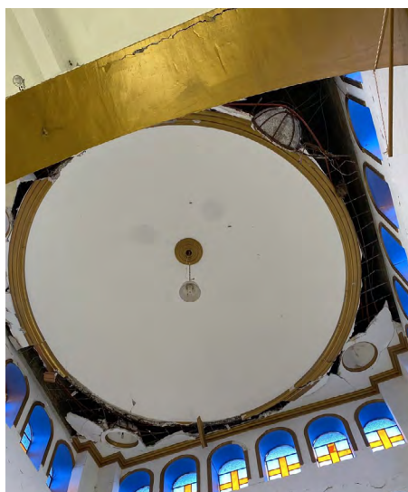
Figura 5.10. Vista interior de la Parroquia, con todos sus elementos estructurales con daño severo
