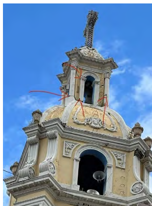
Figura 5.34. Desprendimiento de elementos de la fachada y daño en las columnas del campanario
