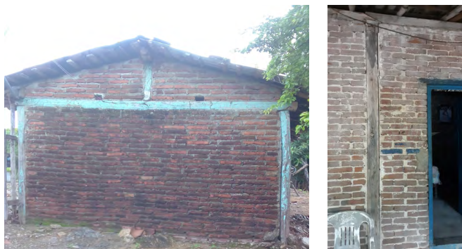
Figura 6.9. Estructuración típica de la región, con muros de mampostería dentro de un marco de elementos de madera
