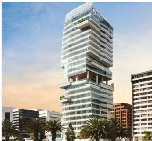
Imagen 9. Edificio de Uribe Schwarzkopf en el sector la Carolina, Quito
