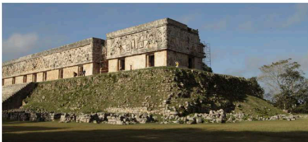
Figura 79. Vista general del palacio del Gobernador antes de la temporada de restauración en 2014 desarrollada por Huchim y su equipo
