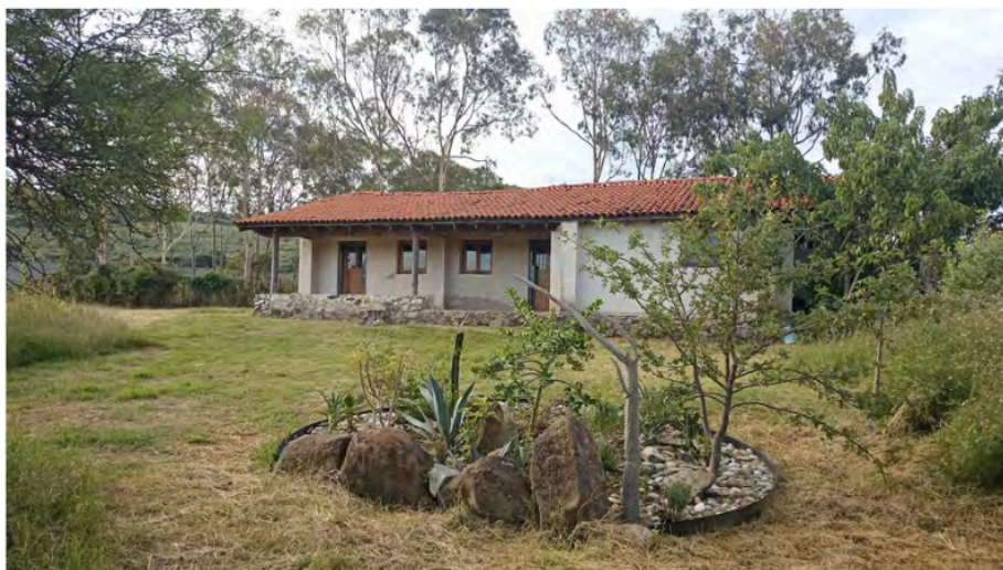
Figura 1. Vista del Salón del CEFAS.
