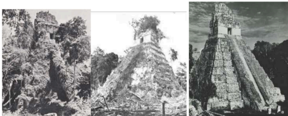
Figura 75. Templo I de Tikal, proceso de limpieza y rehabilitación
