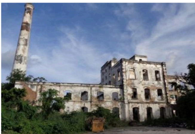
Figura 10: Ruinas del complejo industrial Tacaruna. Fuente: Fotografía de Alcilia Afonso. 2023.
