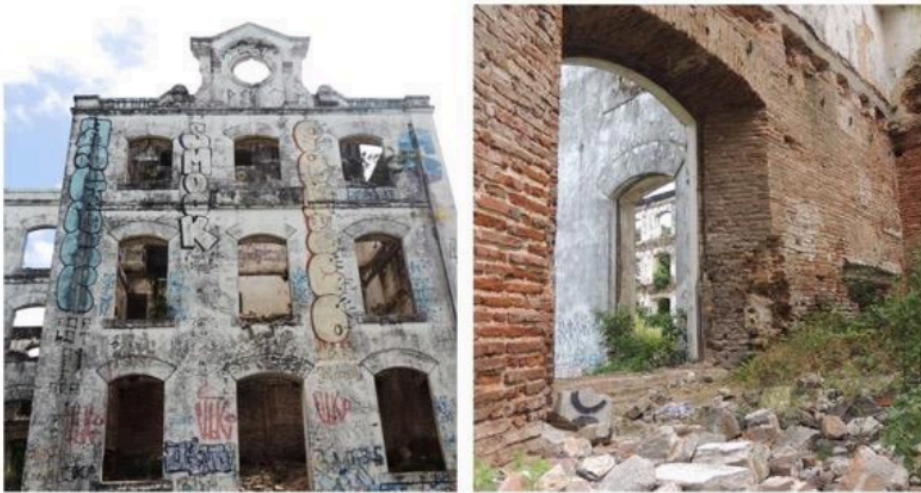
Figura 8: Ruinas del complejo industrial Tacaruna. Fuente: Fotografía de Alcilia Afonso. 2023.
