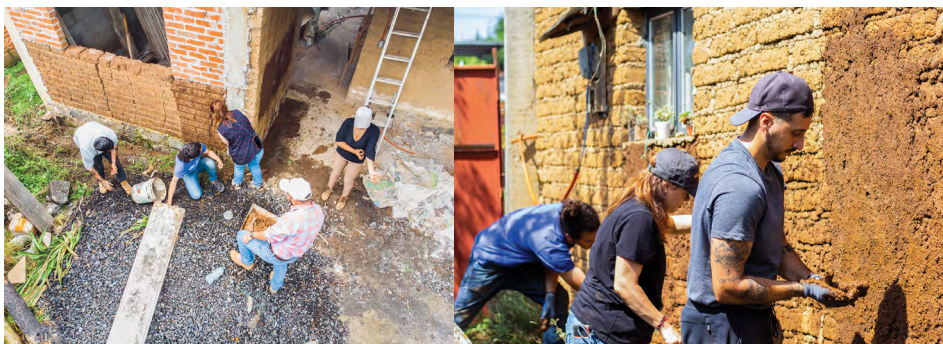
Figura 5. Proyecto de intervención con revestimientos de tierra mejorados en viviendas de adobe de la comunidad de Santa Ana Chapitiro, Michoacán
