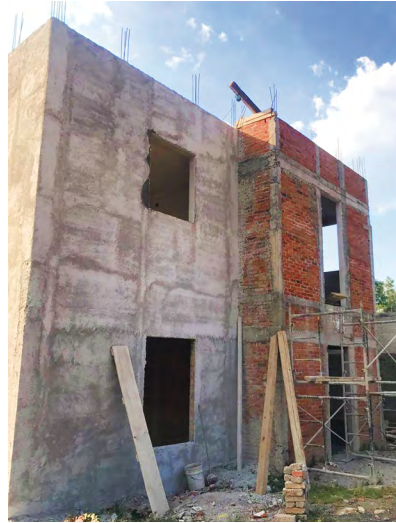
Figura 5. Aplicación de aplanado grueso con morteros de cal. Morelia, Michoacán
