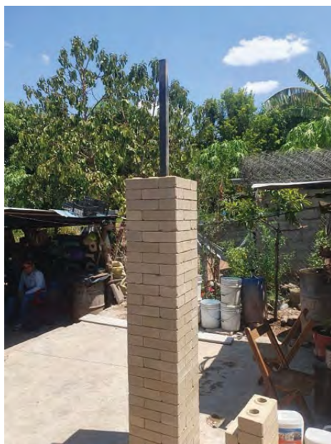
Figura 14. Proceso constructivo de columna con PTR y recubierta de BTC
