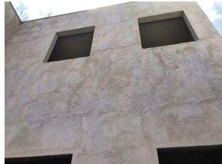
Figura 7. Recubrimiento fino de mortero de cal recién colocado
