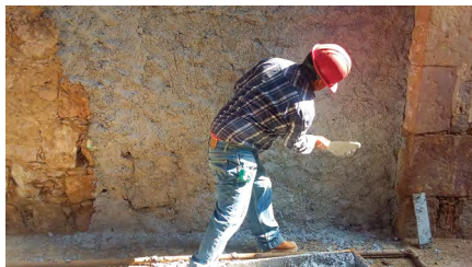
Figura 8. Colocación de mortero de cal en muro de mampostería de piedra
