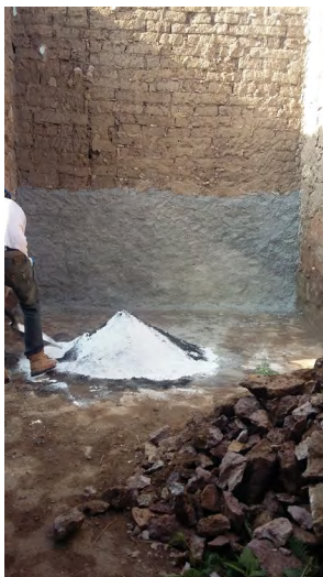
Figura 10. Colocación de mortero de cal en muro de abobe
