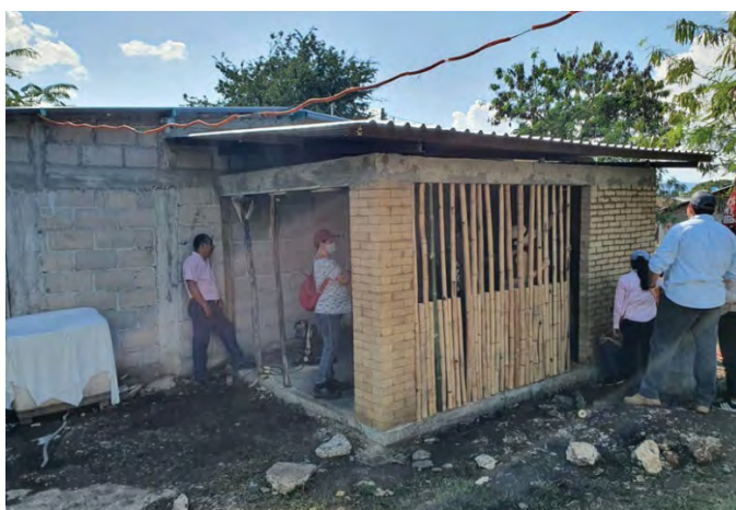
Figura 5. Utilización del bambú en un muro de la Ecocina
