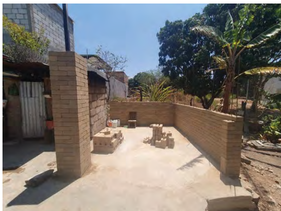
Figura 15. Avance de la construcción de la Ecocina
