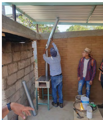
Figura 16. Instalación de estufa ecológica Ecosofía
