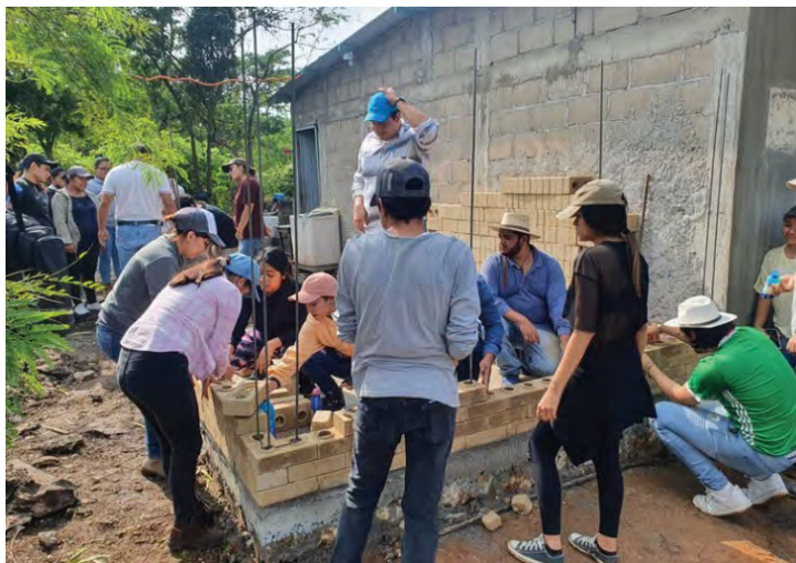
Figura 4. Construcción de muros de BTC con refuerzo interno
