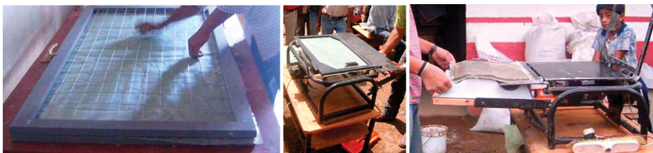
Figura 4. Proceso de elaboración de teja de microconcreto
