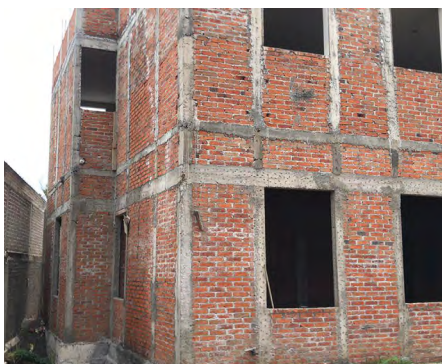
Figura 12. Pegado de tabique rojo y tabicón
