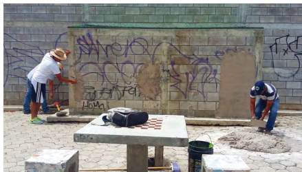
Figura 9. Colocación de mortero de cal en muro de block
