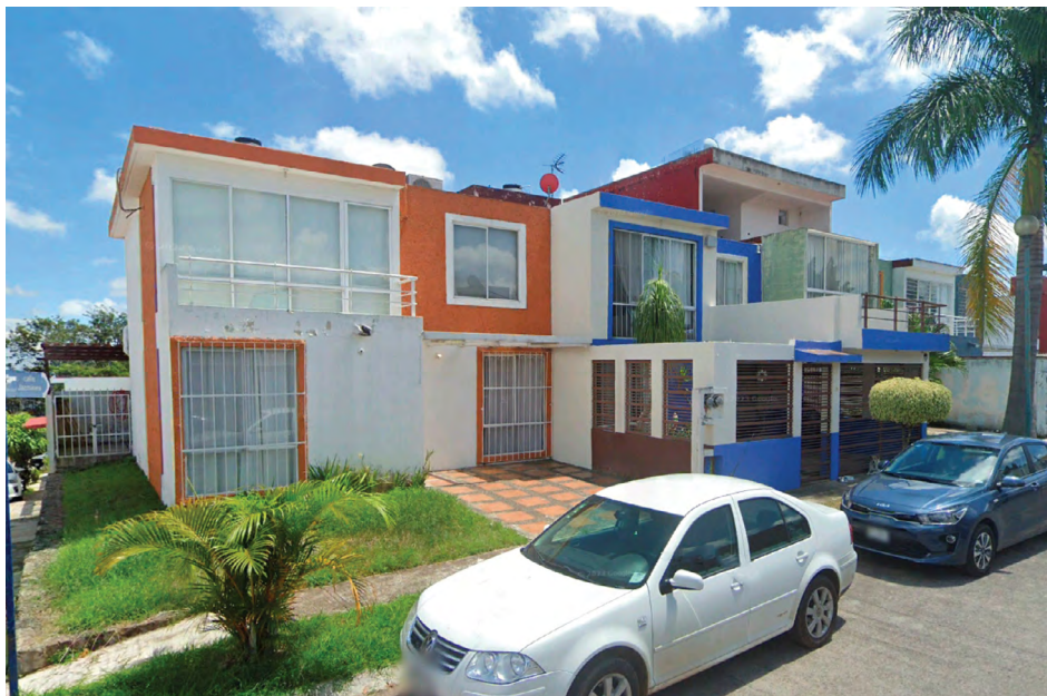
Figura 9. Tipología de vivienda, Fraccionamiento Gravileas
