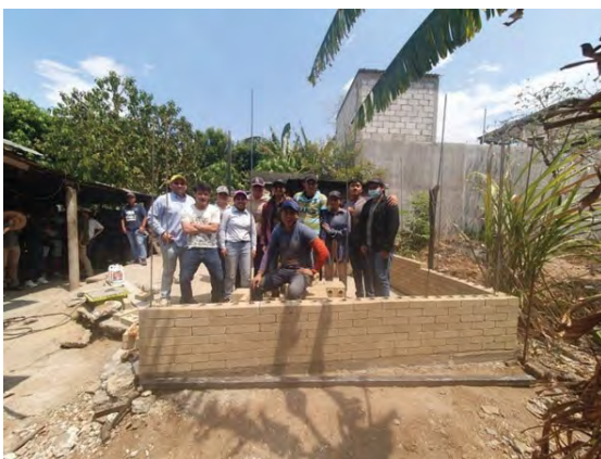
Figura 13. Proceso constructivo de los muros de BTC
