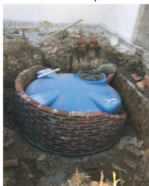
Figura 13. Colocación de mampostería con morteros de cal para cisterna
