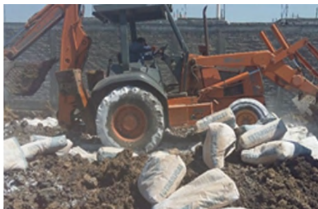
Figura 16. Suministro y mezclado de la cal
