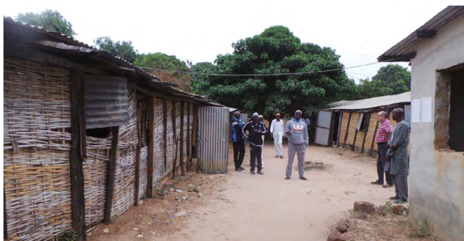
Figuras 1 y 2. Estado actual de la escuela construida
