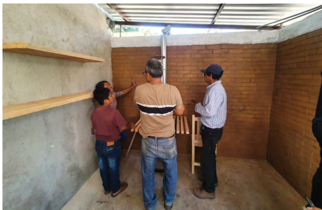
Figura 6. Instalación de la estufa ecológica Ecosofía
