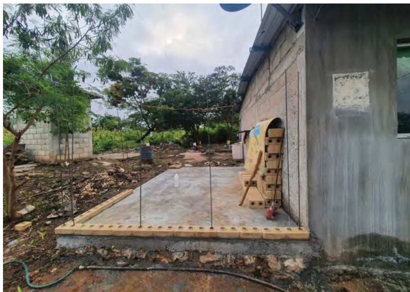
Figura 3. Cimentación y primera hilada de BTC
