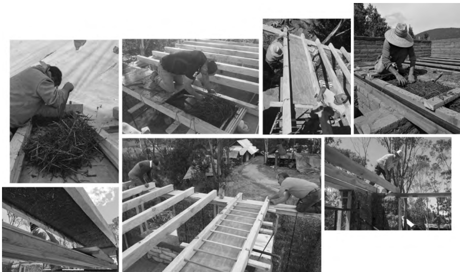
Figura 1. Proceso constructivo del entrepiso de pajarcilla
