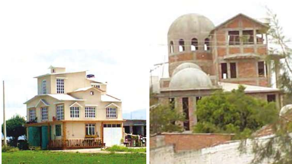
Imagen 19.6. La construcción de viviendas nuevas sin habitar, se considera la evidencia más extrema de considerar a la casa como escenario de autorrealización
