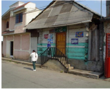
Se sustituye el tejamanil por lamina y el cambio de color, evidencia un nuevo uso de la troje
