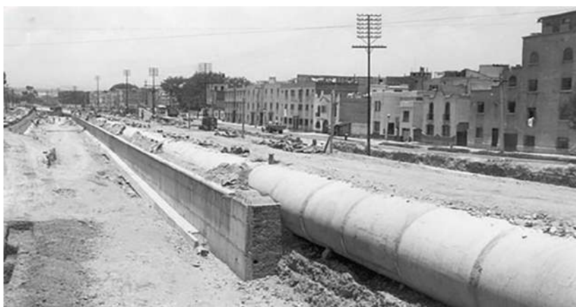
Figura 15. Entubamiento del río de la Piedad
