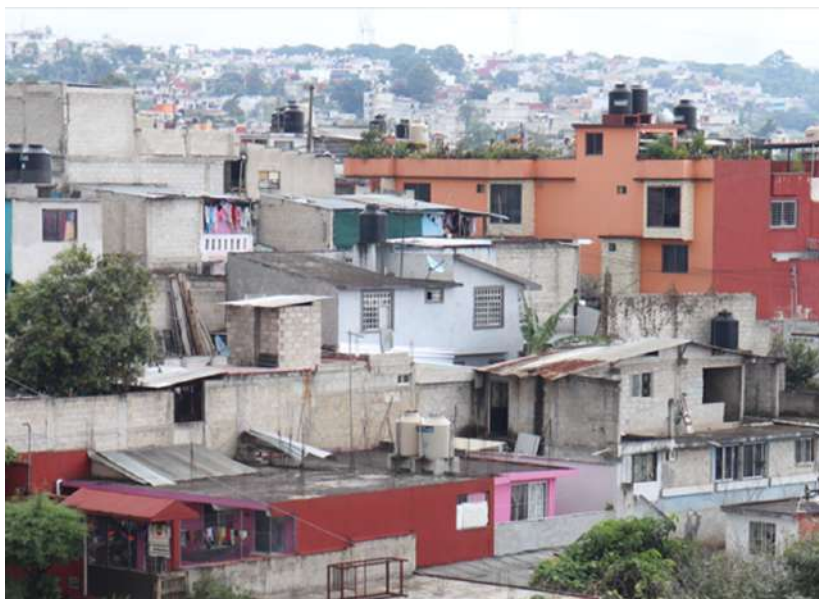
Figura 2. Viviendas populares de la periferia de Xalapa, Ver. con elementos deteriorados
