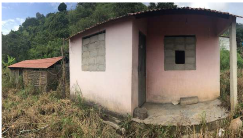
Figura 1. Vivienda rosa en la comunidad Francisco I. Madero, Chiapas
