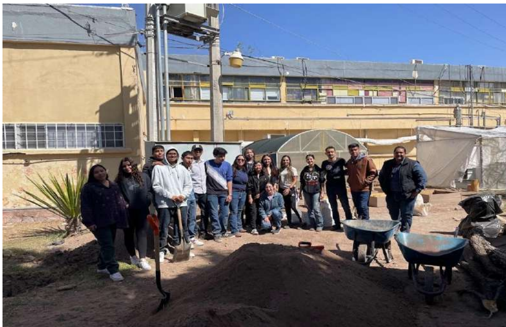
Figura 1. Construcción de HELAF por estudiantes de ingeniero horticultor. Fuente: Mayra Salazar (2024).
