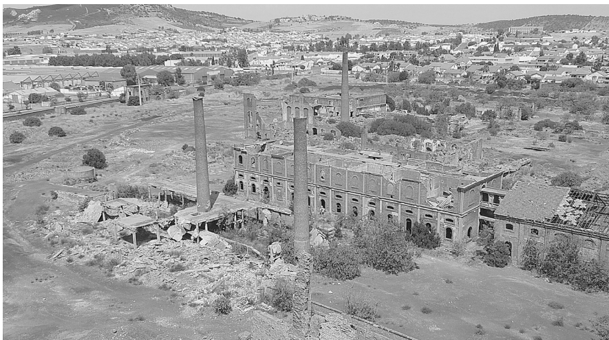
Figura 9.7. Imagen que muestra el estado de ruina de los inmuebles. En ella encontramos en primer plano la Fábrica de Zinc derruida en la que solo permanecen dos de sus chimeneas, tras ella, los restos del Almacén de Productos Refractarios, ambos contruidos en hormigón armado y, al fondo, la Fábrica de Ácido Sulfúrico de la cual solo se conserva su chimenea
