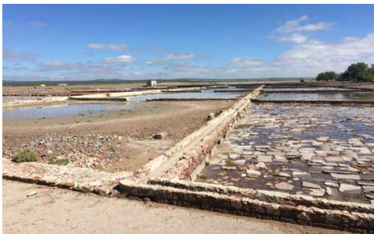
Figura 8.3. Canal de mampostería
