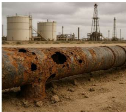
Figura 5.1. Tubería corroída en la industria del petróleo
