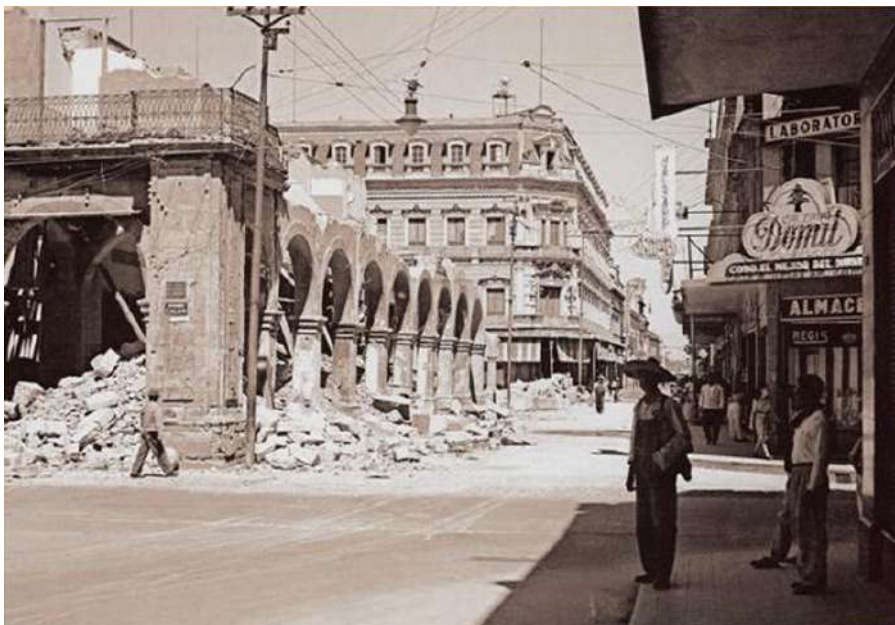
Imagen 6.4. Ampliación de la avenida Vallarta
